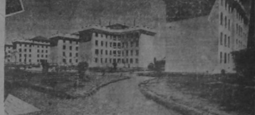
Conjunto de casas colectivas que forman el barrio "Guillermo Fajardo"
